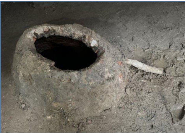
Links: bij het uitgraven van de vloer van het souterrain werd een oud waterreservoir gevonden. Vanuit dat reservoir liep een loden leiding in de richting van de plaats waar de waterpomp moet hebben gestaan. Rechts: de onderkant van de grotere tegels op de muur geeft het vloerniveau aan zoals dat tot voor kort was. Bij het uitgraven werden daaronder resten van Delftsblauwe tegeltjes aangetroffen. Die geven aan dat het oorspronkelijke vloerniveau van het souterrain zo'n 25 centimeter lager moet hebben gelegen.
